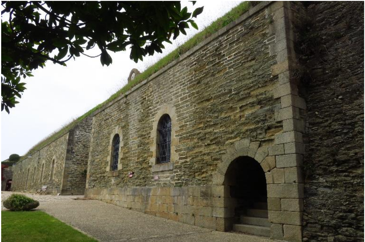
Le Palais, citadelle, caserne à l'épreuve, façade.
