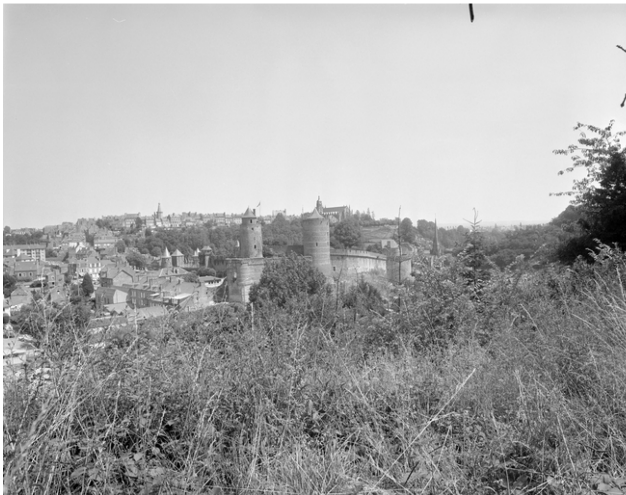
Vue de situation nord-ouest.
