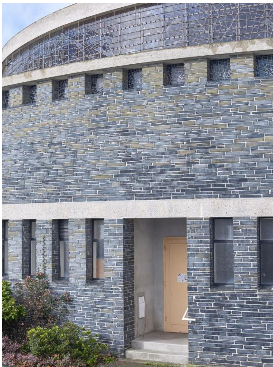
Eglise Sainte-Thérèse, Le Landais : vue de la façade sud, béton et parement de schiste ; dimensions différentes des ouvertures selon la fonction
