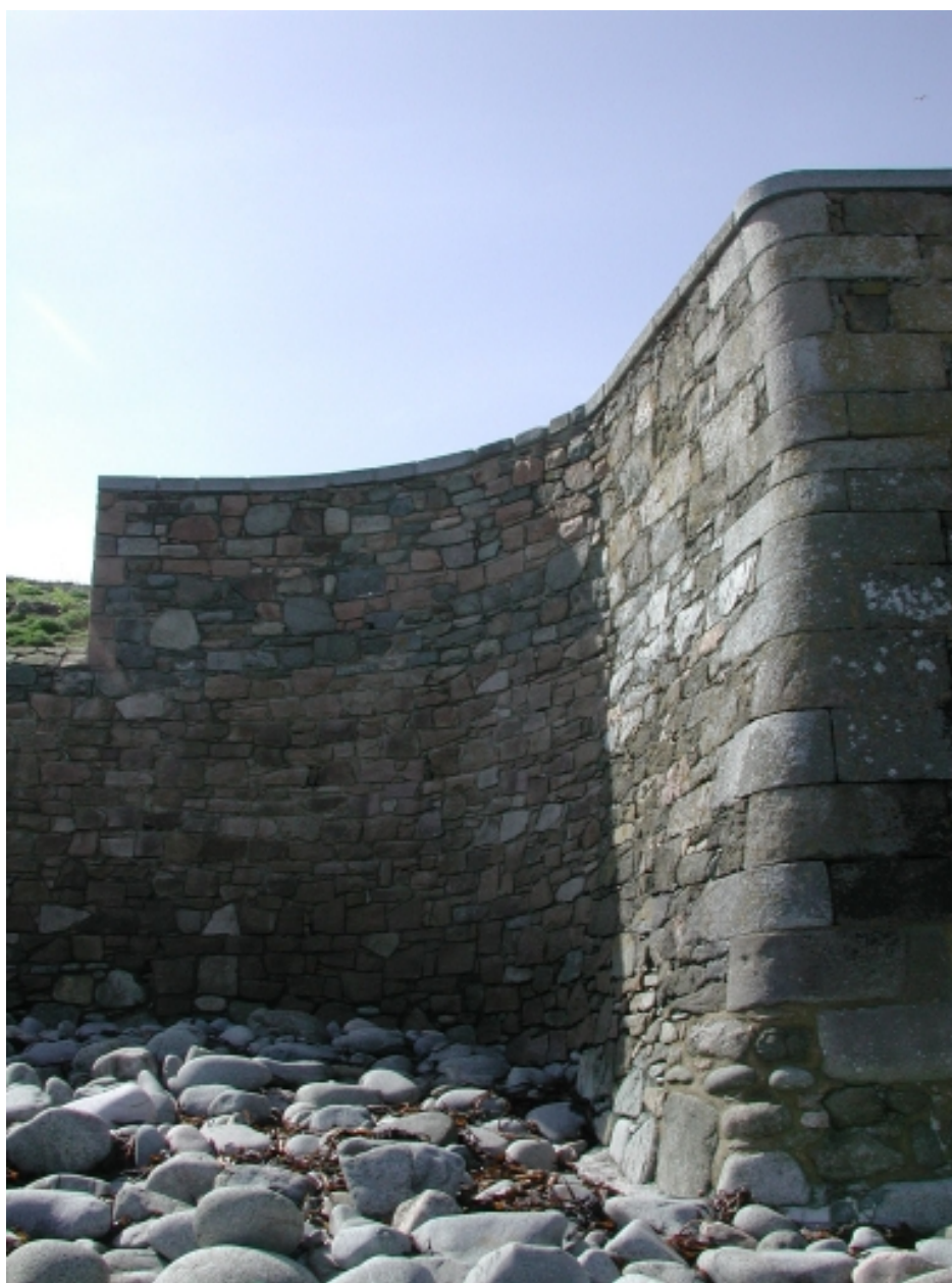
Vue de la forme du mur d'enceinte de la caserne, en prolongation du mur de soutènement
