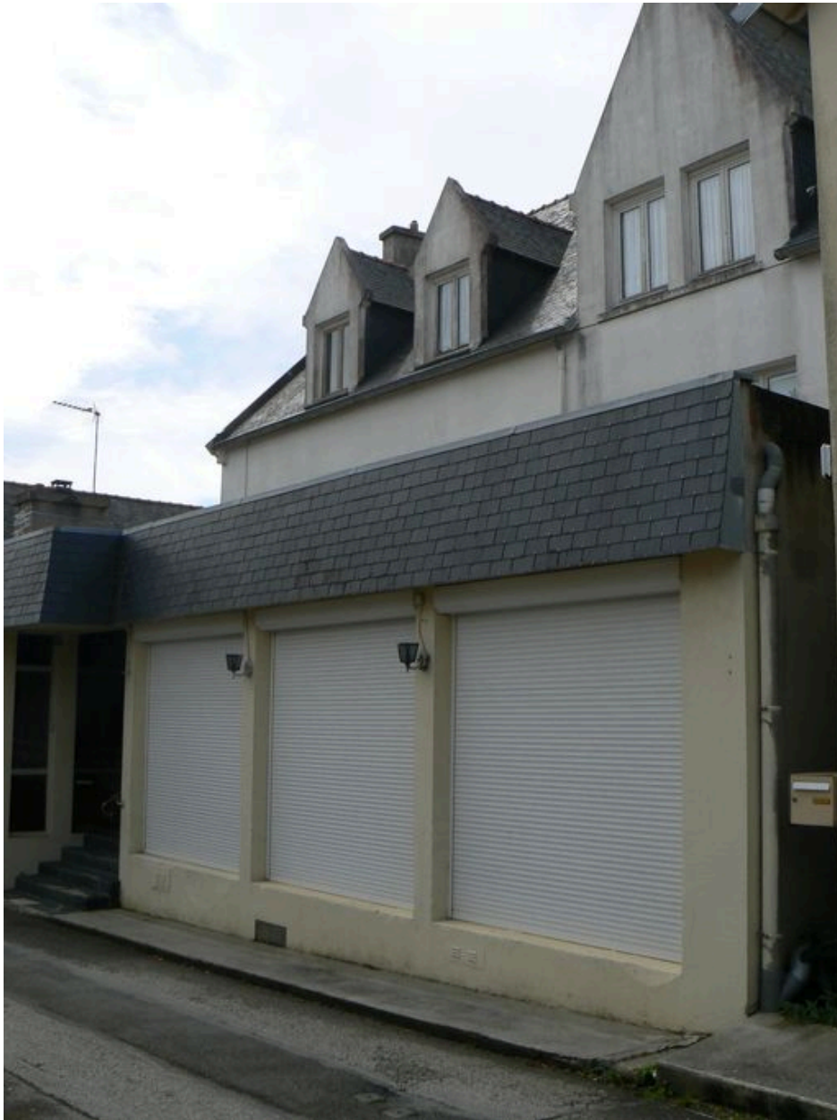
Vue générale de l'hôtel Kreis-Ar-Mor
