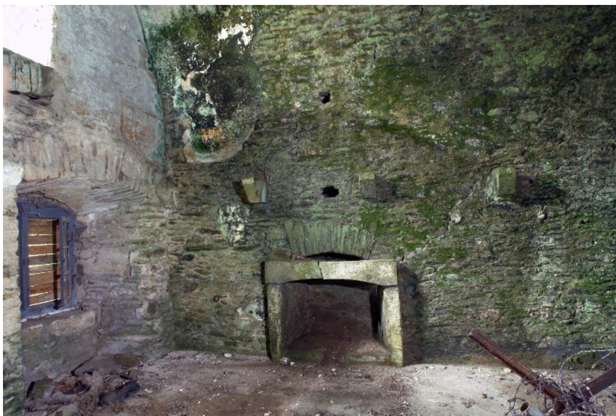
Brest : le fort de Penfeld, photographie réalisée le 13 mai 2009
