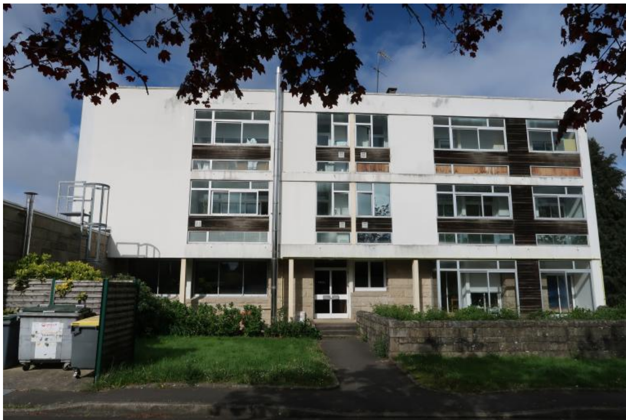
Bâtiment A, façade est des logements de fonction. Louis Arretche et Jean Monge, architectes, plans 1959.
