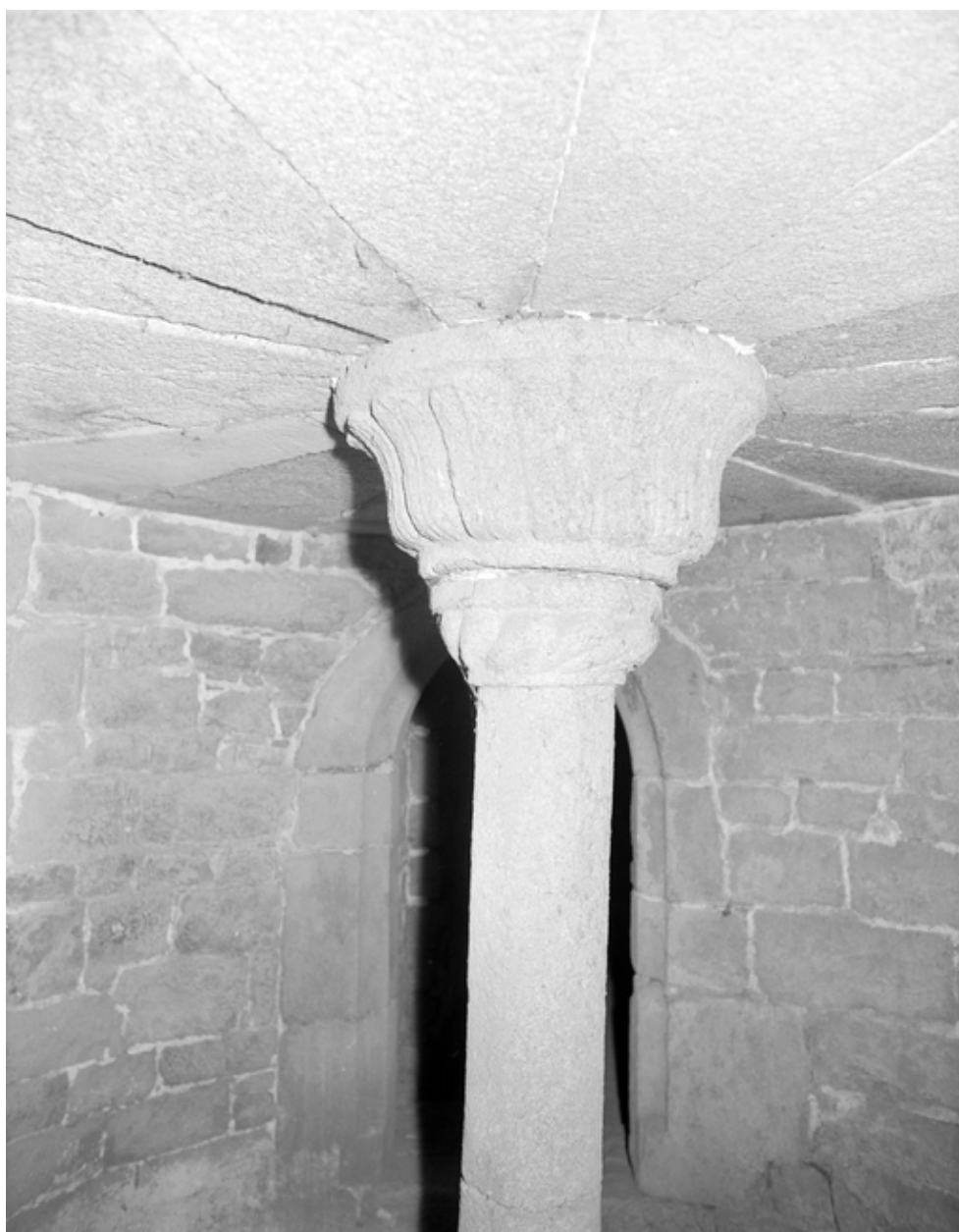
Chapiteau couronnant l'escalier de la tourelle
