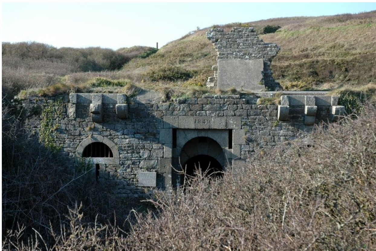
Vue générale depuis le sud (état en 2006)
