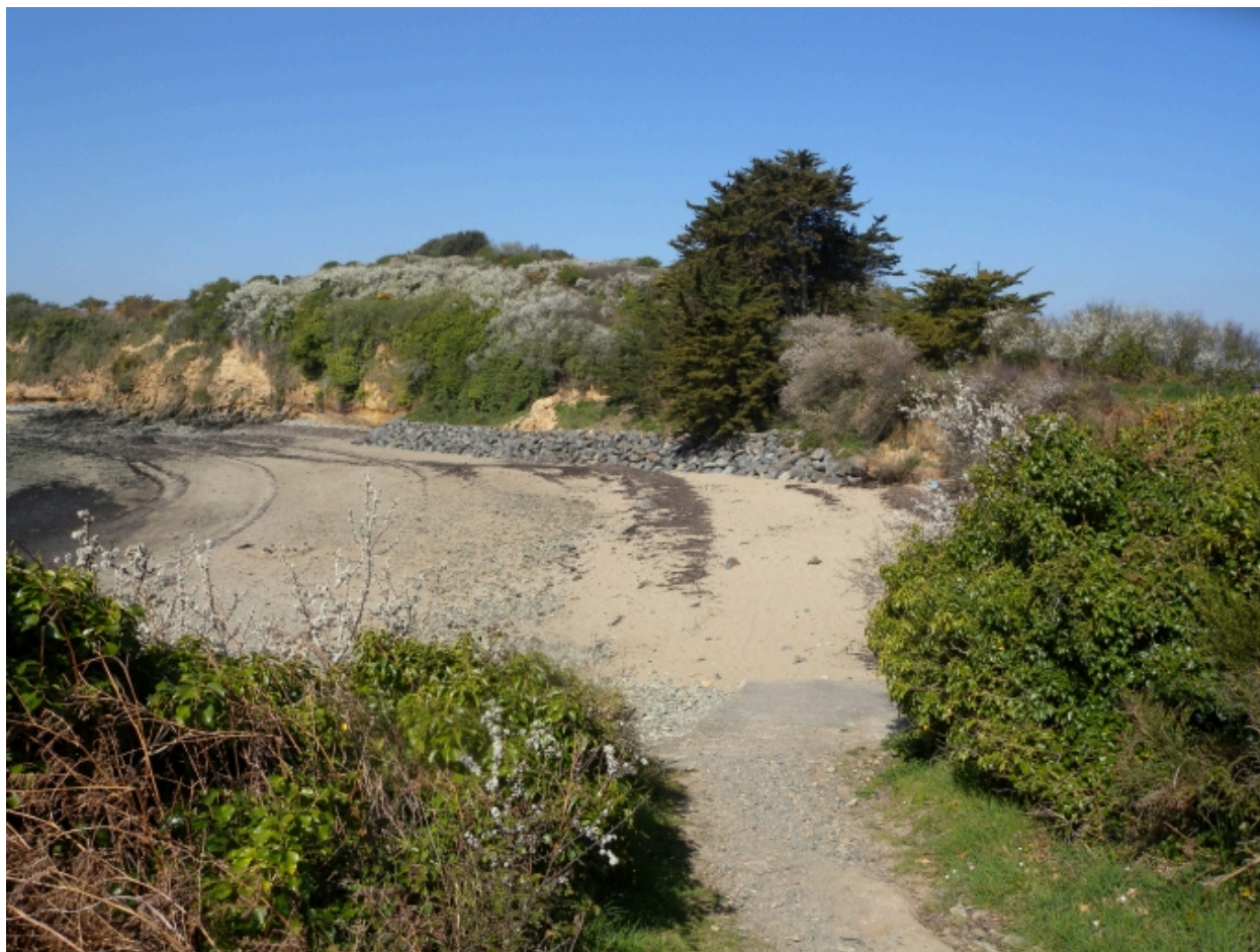
Vue des enrochements sur la côte Sud-Est
