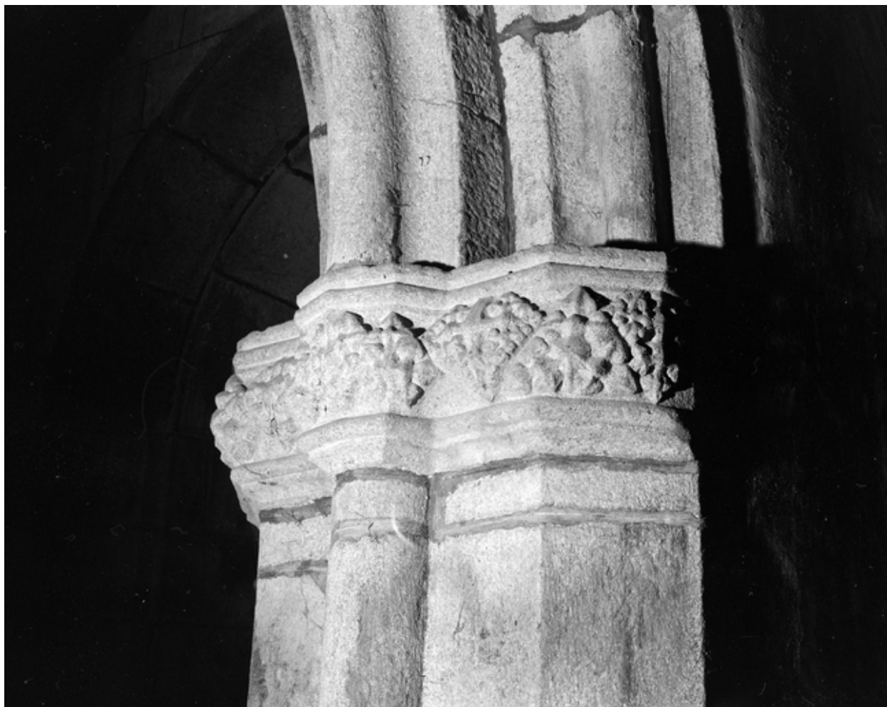
Première pile nord, chapiteau
