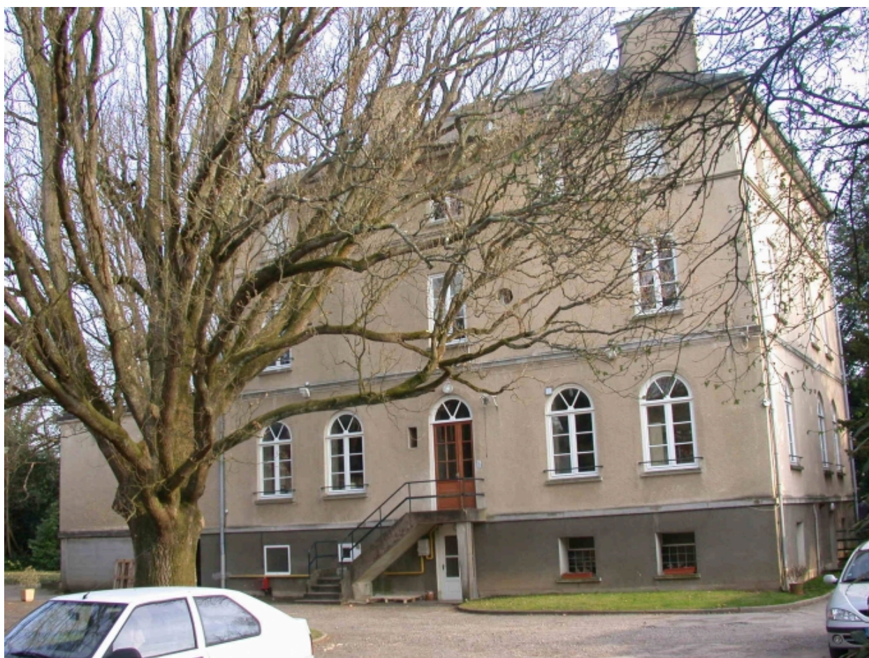
Façade arrière du logis
