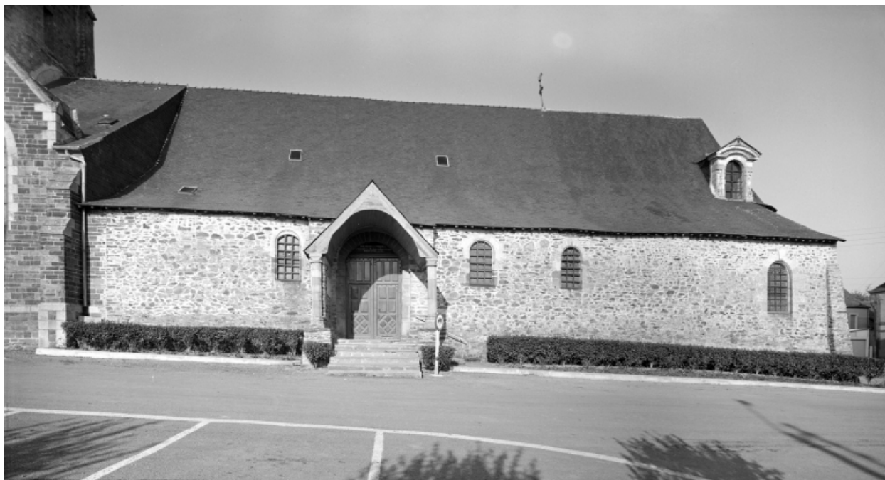
Elévation Sud, partie Est : vue générale
