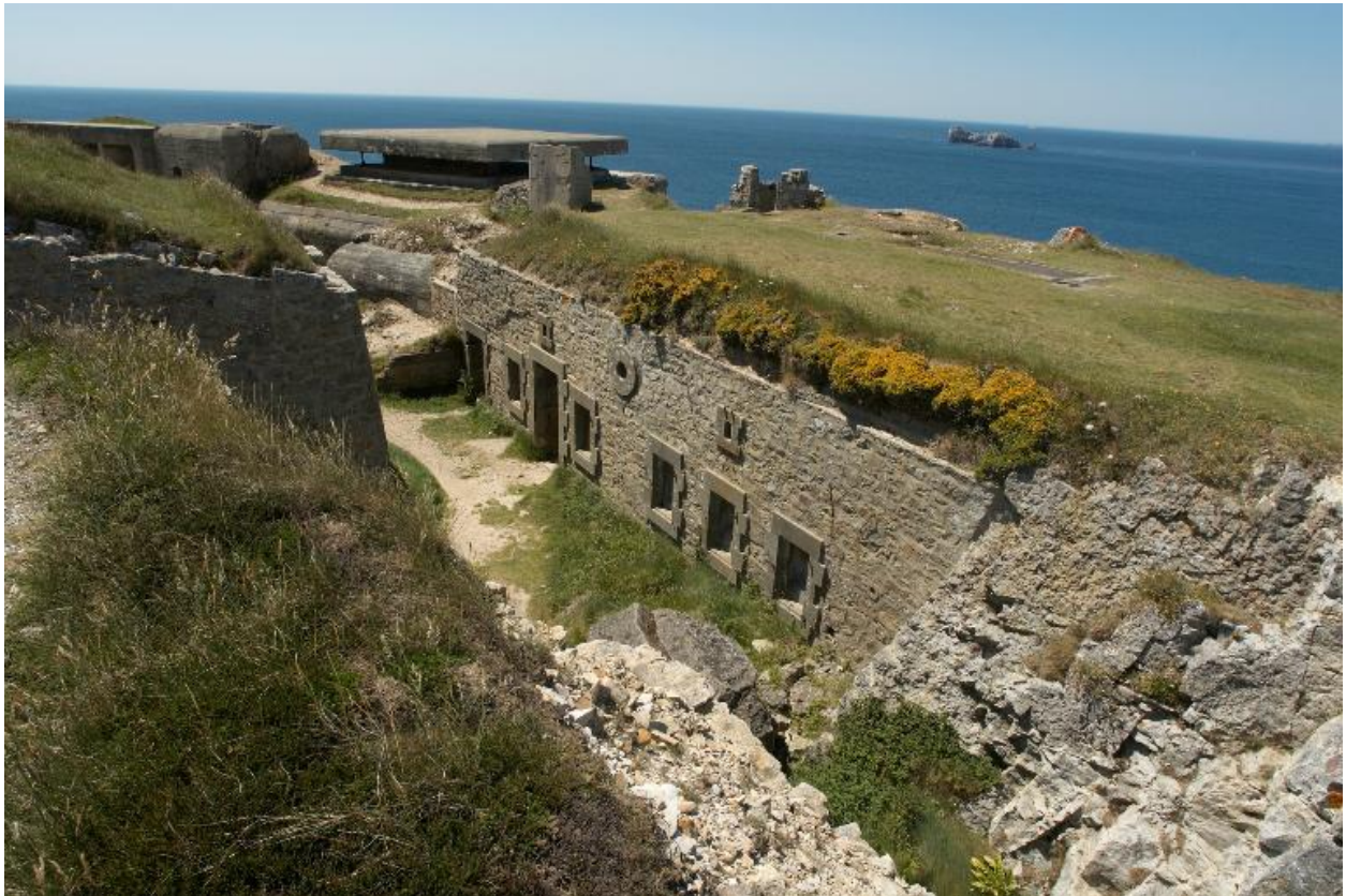
Vue de l'extrémité de la batterie française de mortiers : abri double sous traverse en maçonnerie. En arrière-plan, le bunker - poste de direction de tir de type M162a
