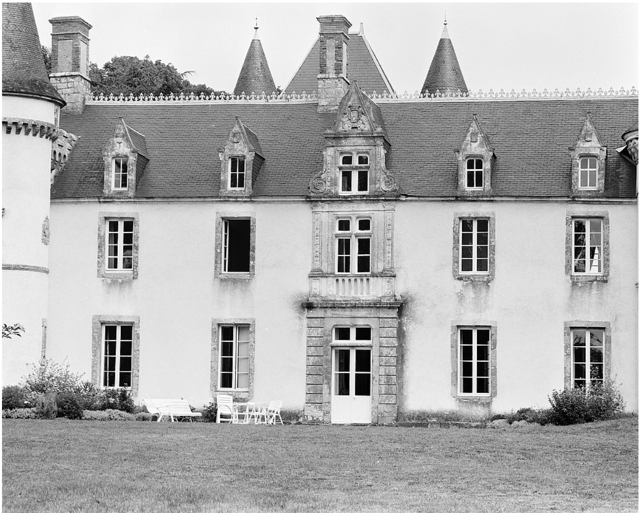
Elévation sud, partie partie centrale.
