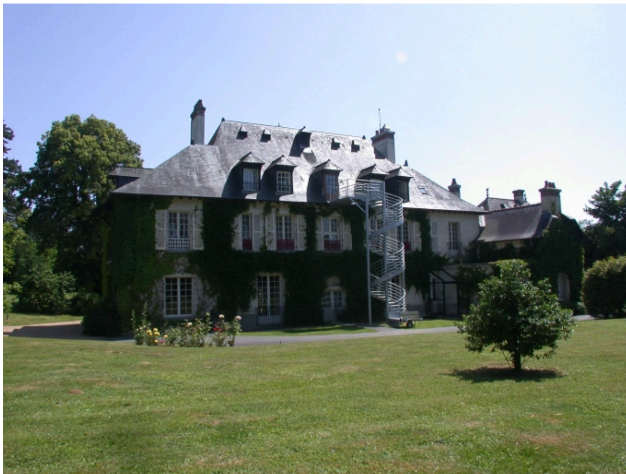
Vue générale arrière de la maison de maître
