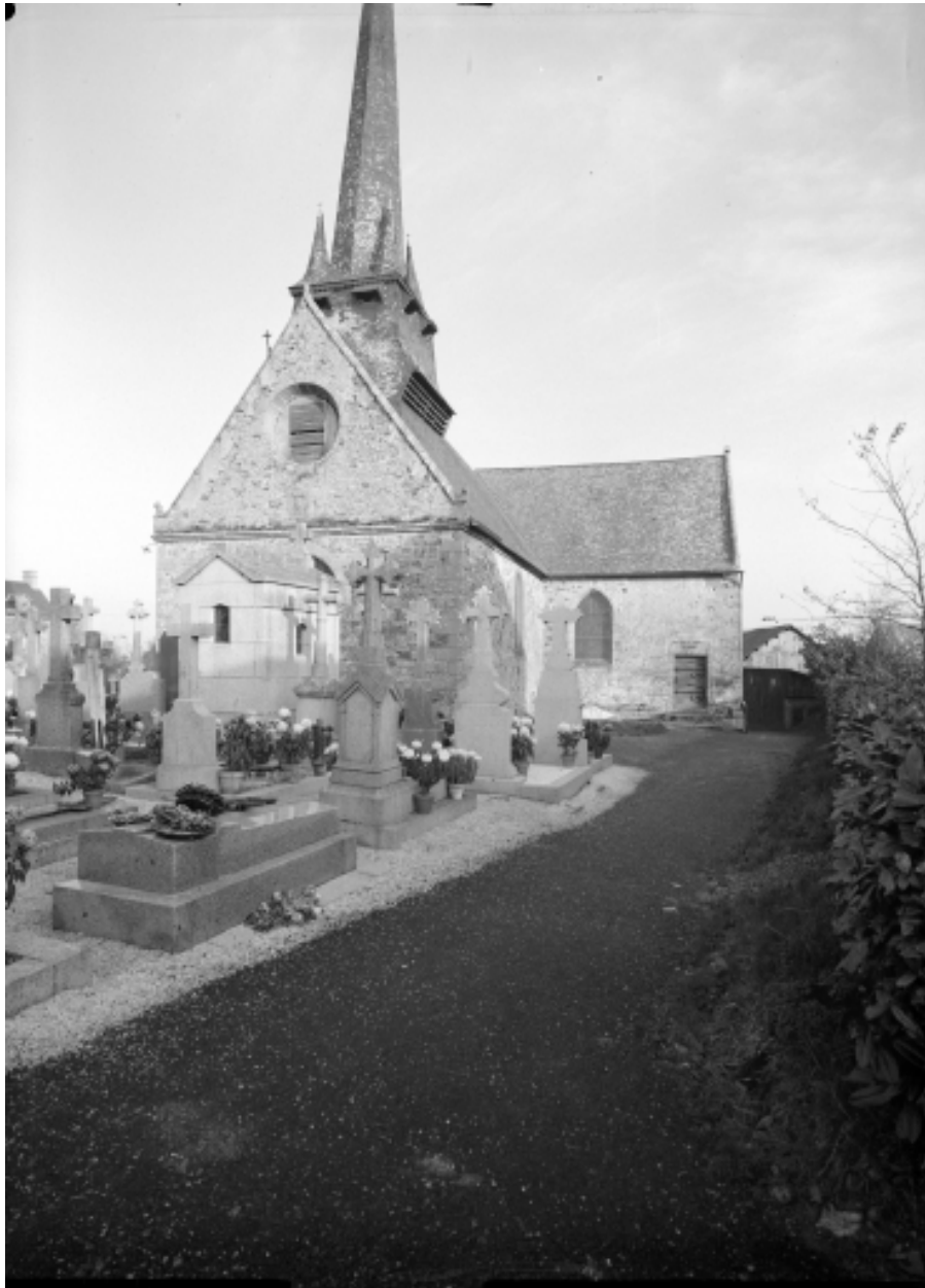
Elévation ouest : vue de situation
