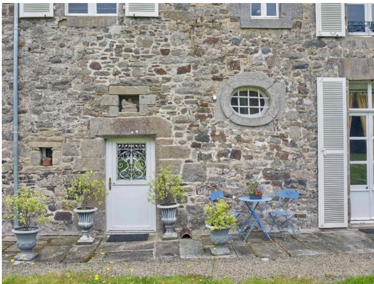
Façade postérieure, détail des ouvertures.
