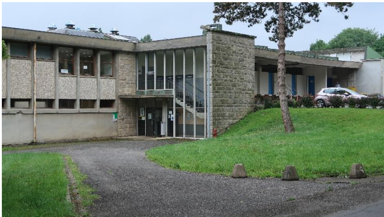
Escalier vitré hors œuvre du bâtiment T.
