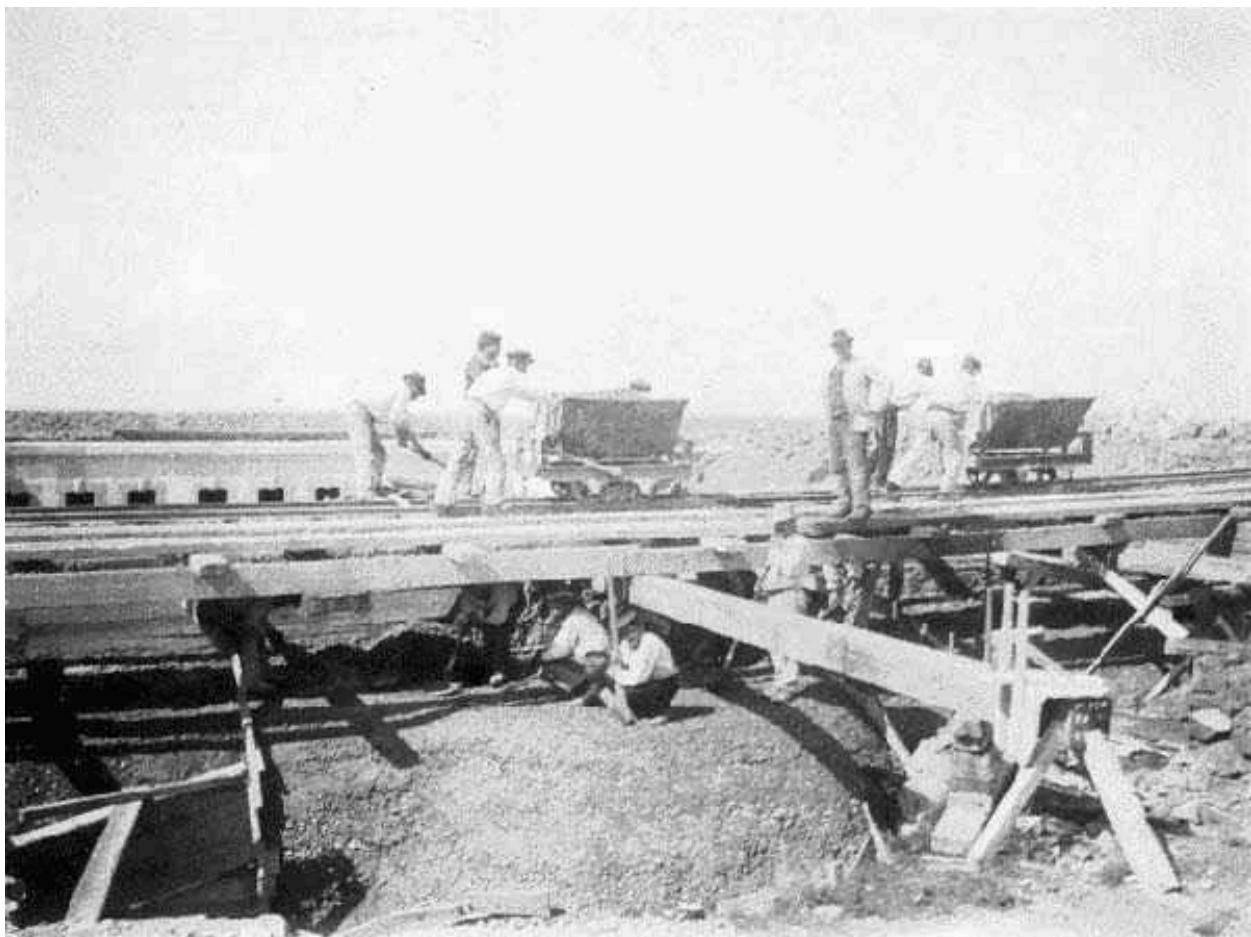
Vue du chantier de construction du réduit, vers 1902-1906 : voie ferrée de type Decauville sur laquelle évolue deux wagonnets poussés par des hommes
