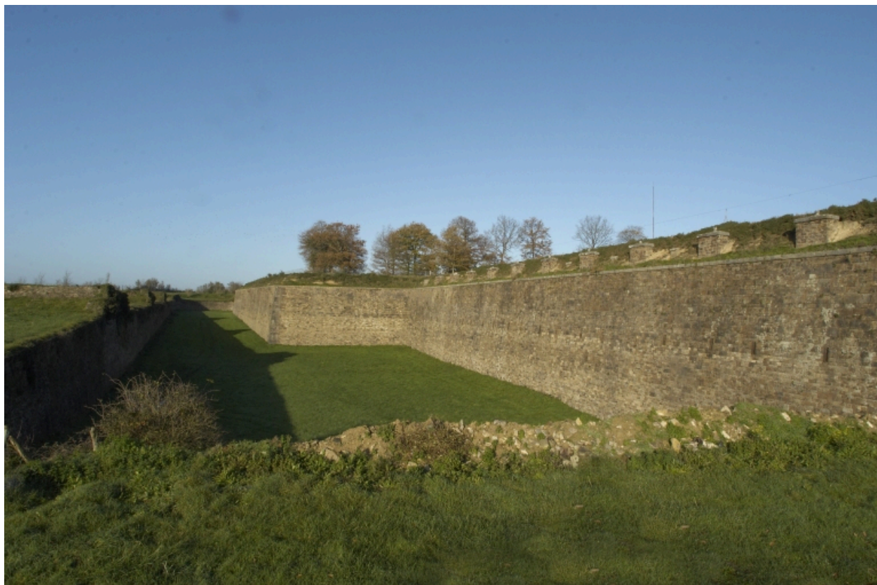
Vue générale du front sud
