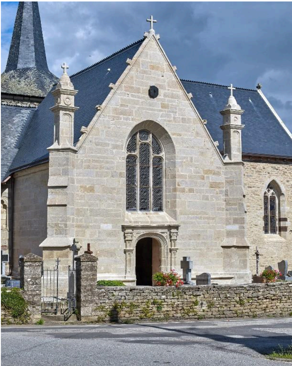
Pignon sud de la chapelle
