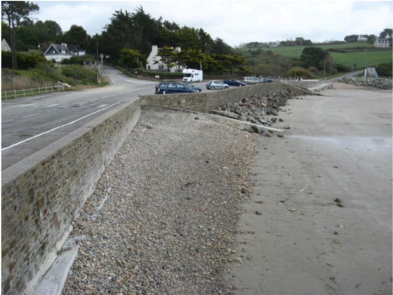
Vue générale de la digue-route de Postolonnec
