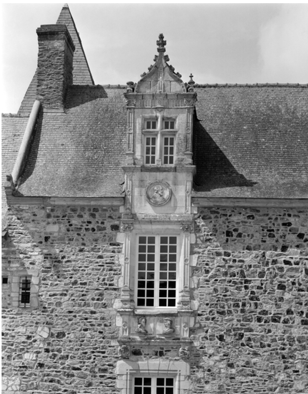
Elévation principale : lucarne sud.
