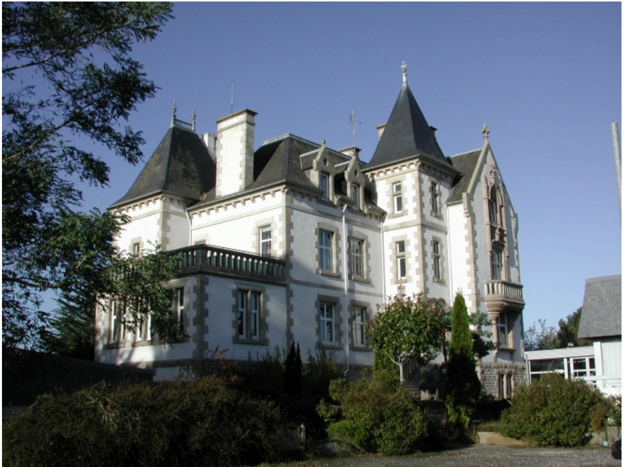
Vue générale (façade postérieure)
