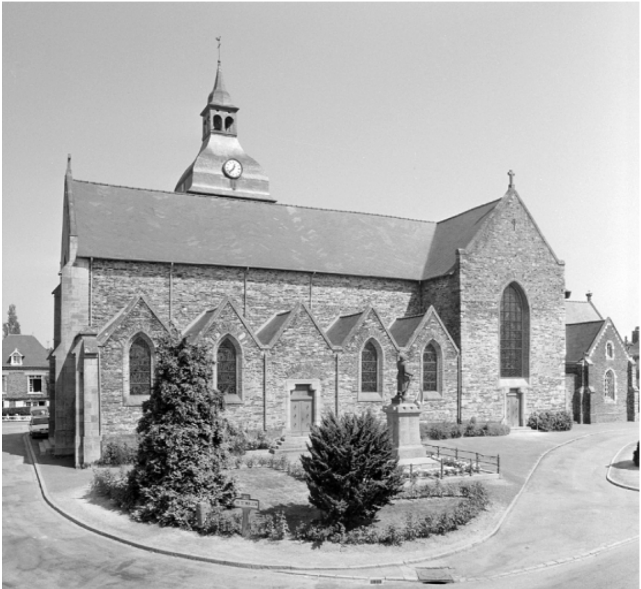
Vue générale sud
