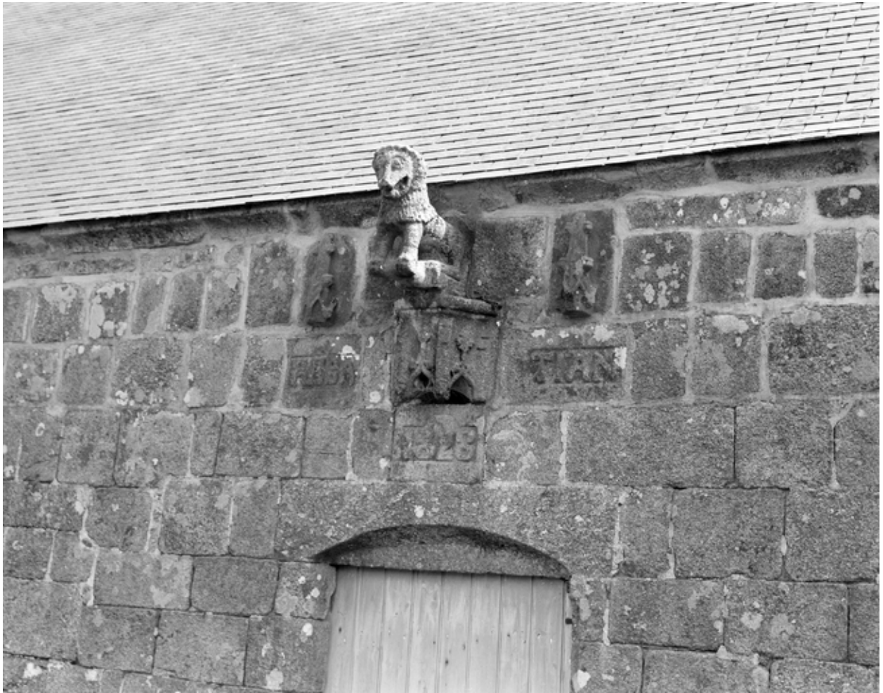
Face nord : détail porte et fleuron la surmontant
