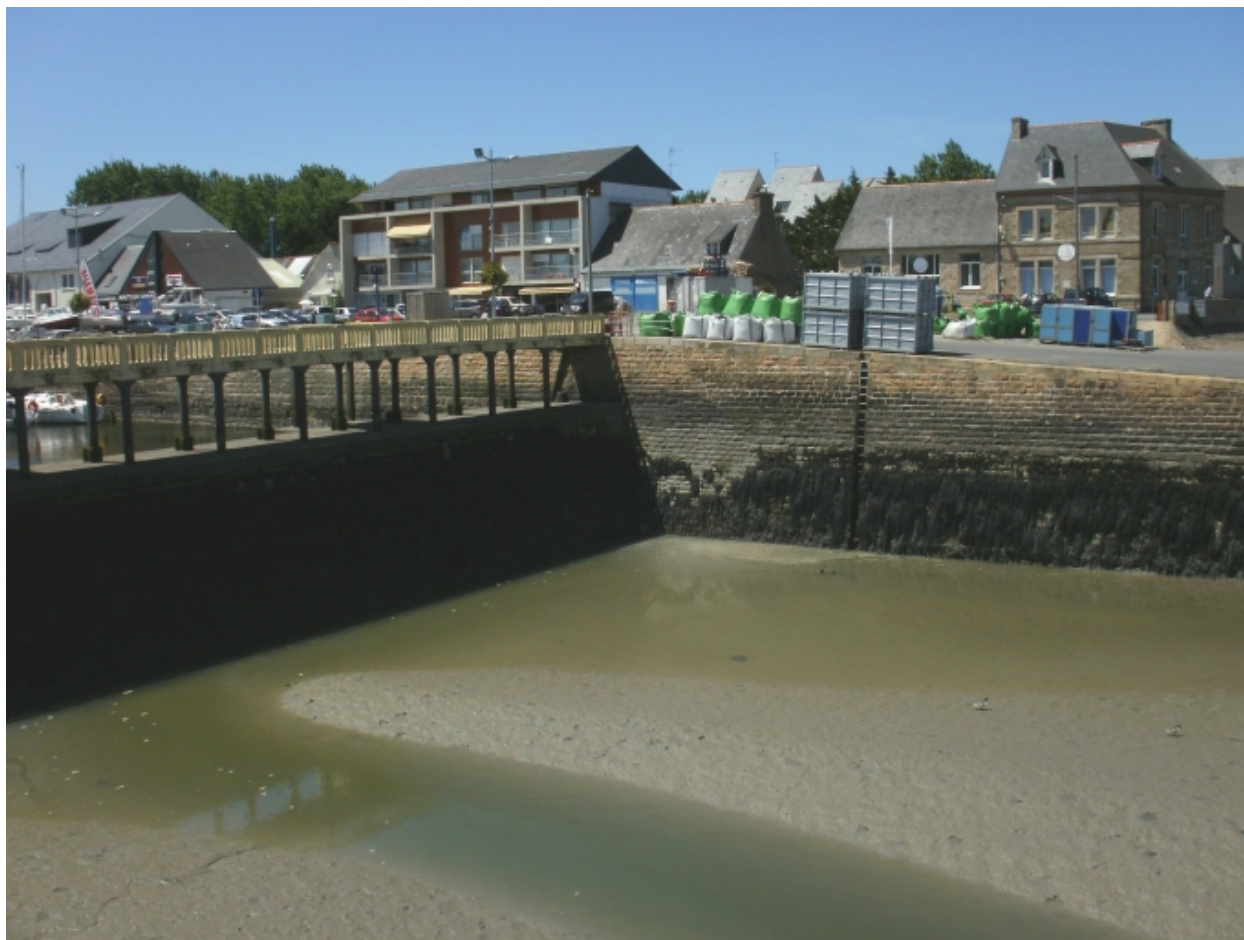
Vue de la passerelle du déversoir à marée basse et du quai des Bréhatins
