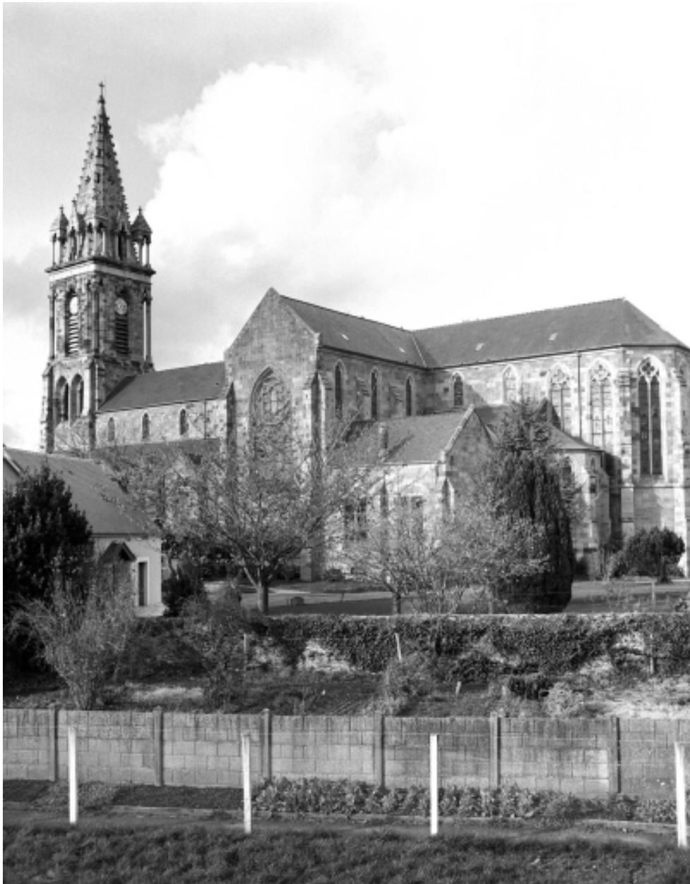
Elévation sud est ; vue générale
