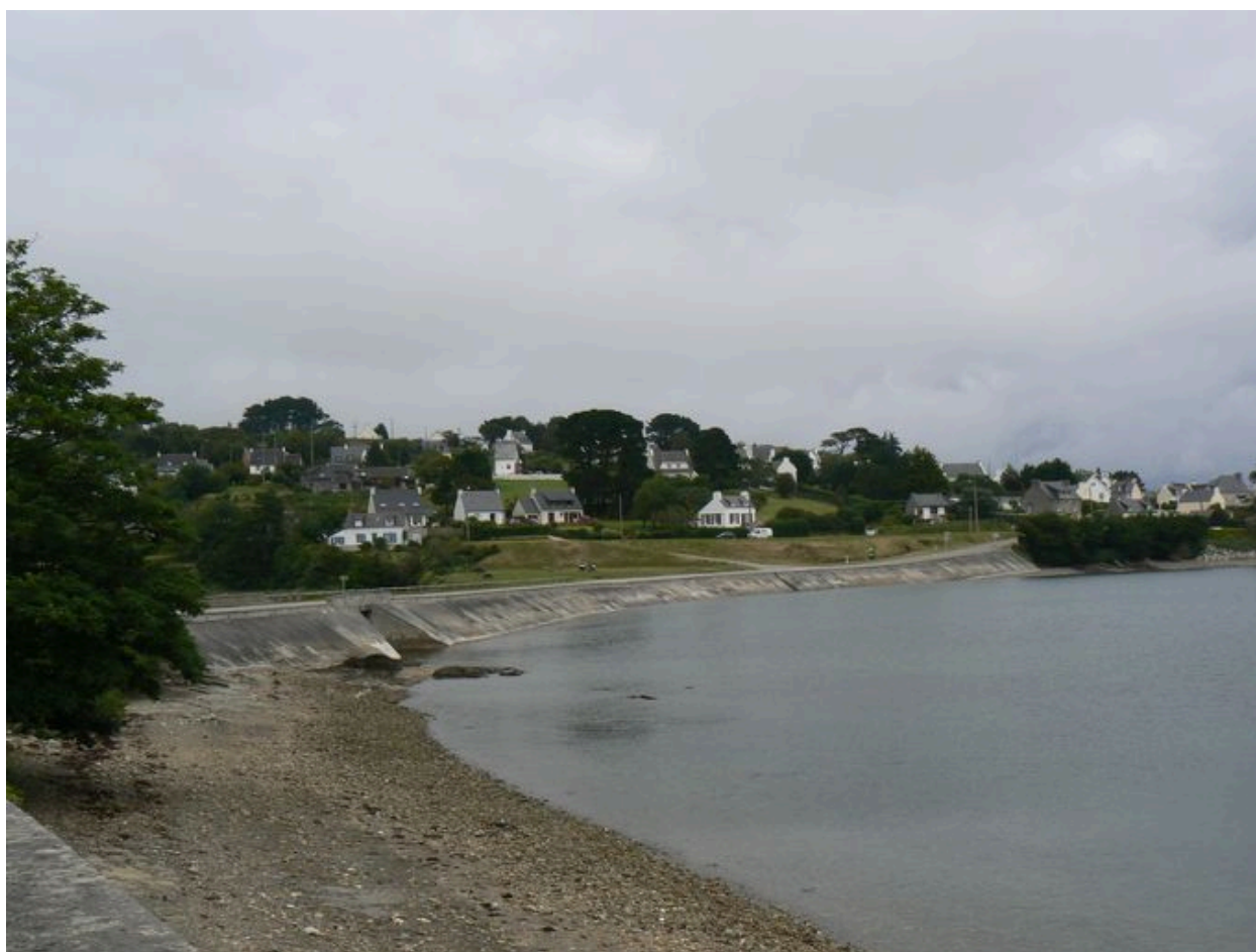
Vue générale de la digue-route de Kervian
