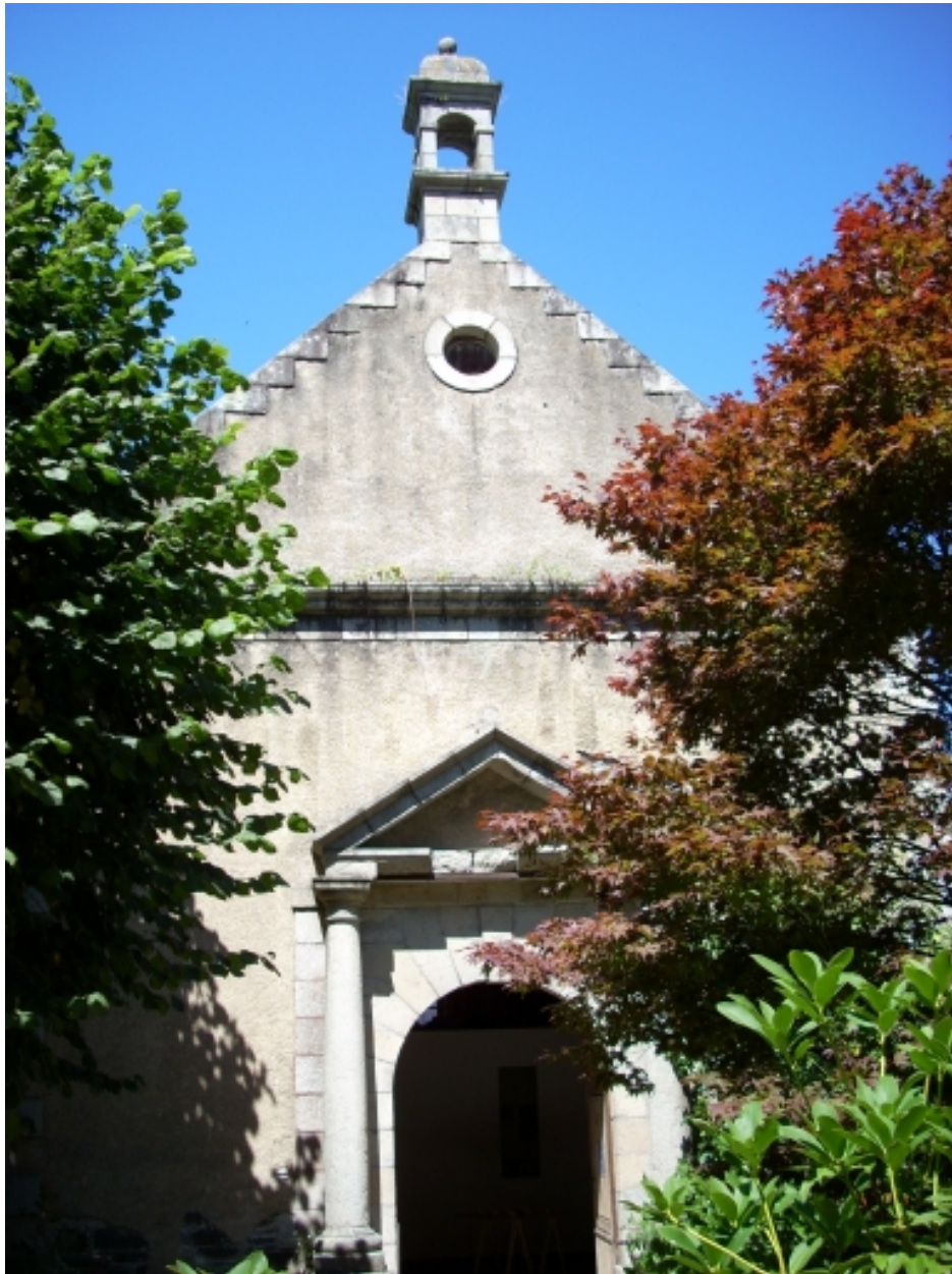
Morlaix, chapelle Notre-Dame du Mur : élévation sud
