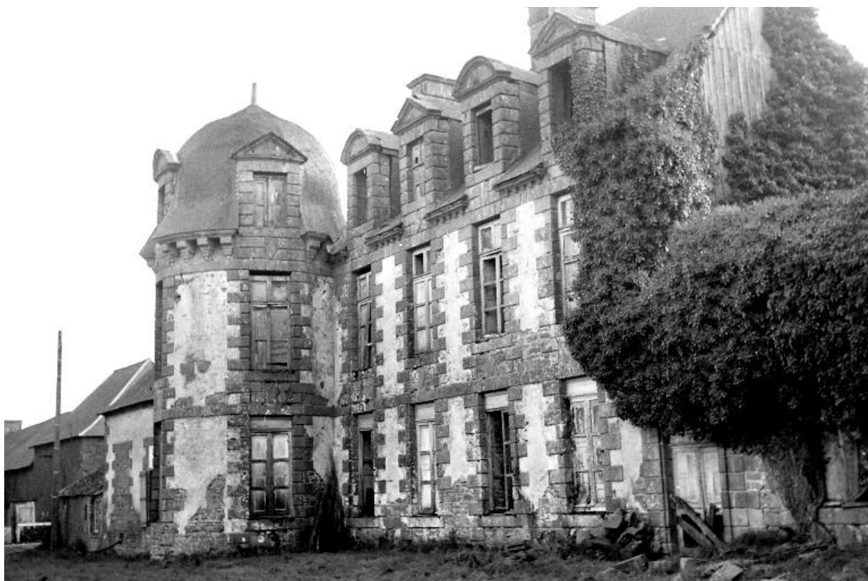
Vue sur la façade nord est
