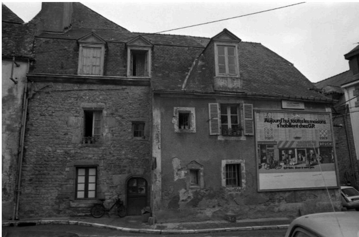
Façade en maçonnerie donnant sur la Place aux Roues
