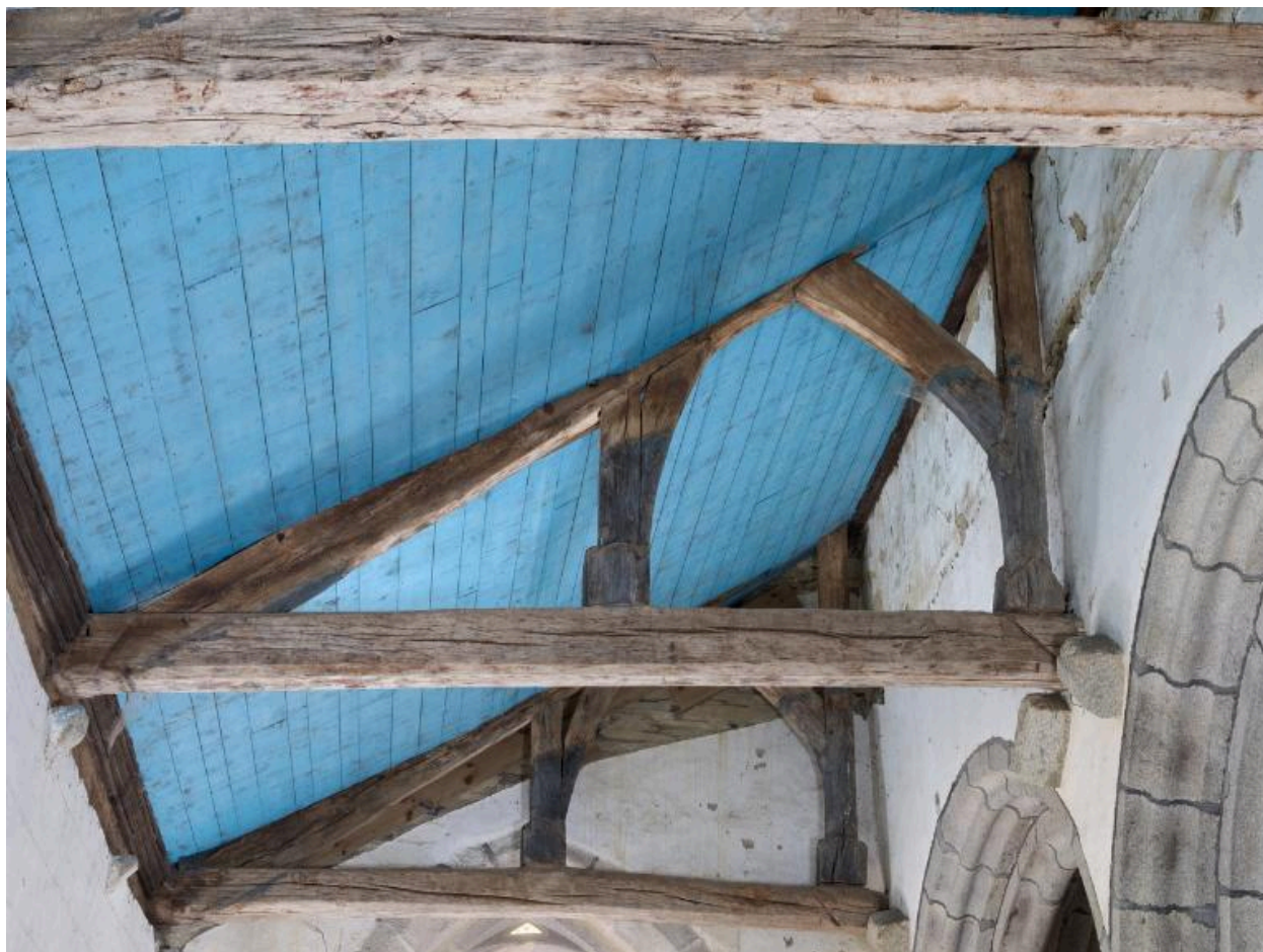
Charpente du bas côté nord
