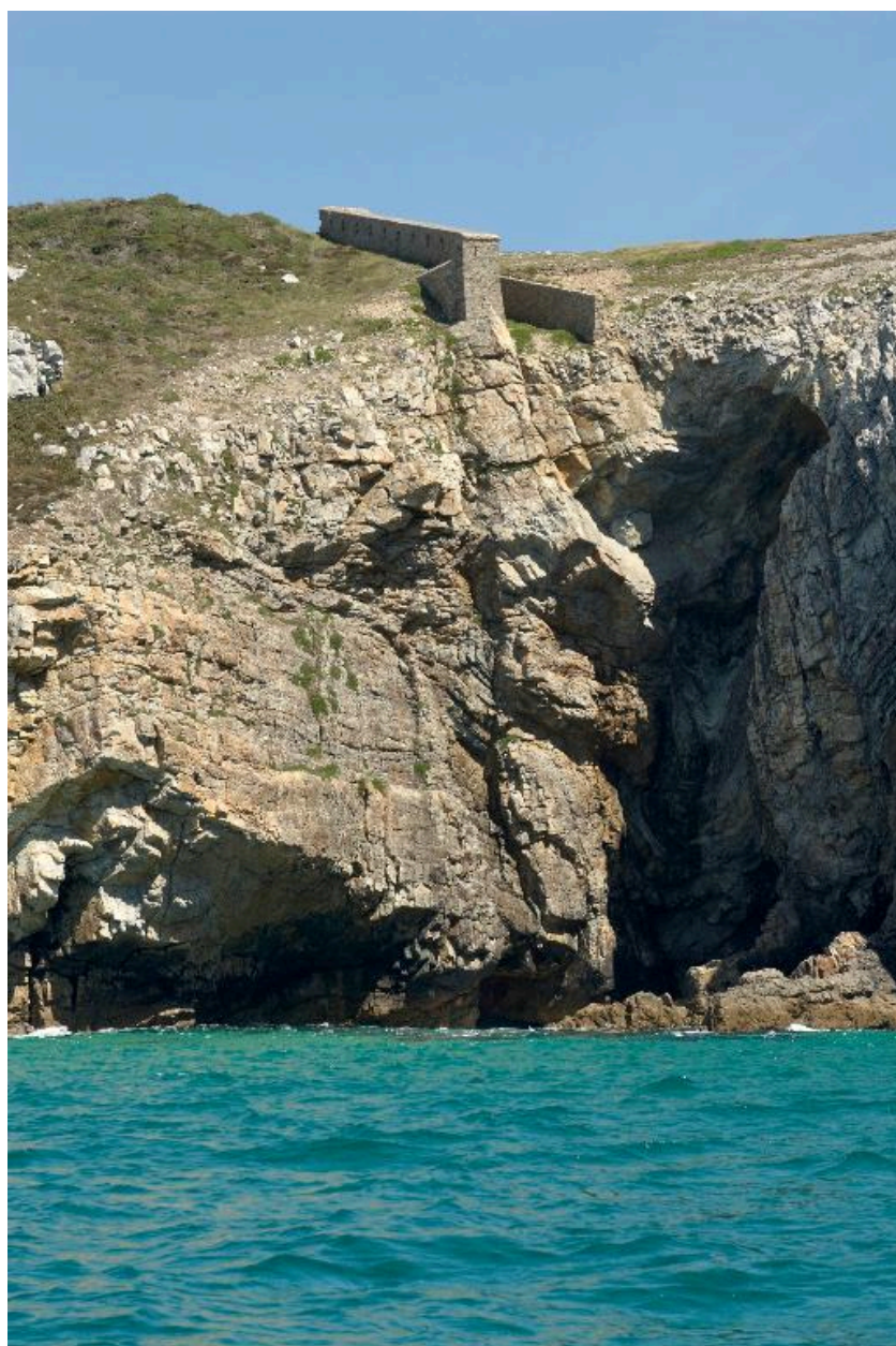
Camaret-sur-Mer, pointe du Toulinguet : vue du mur défensif percé de créneaux de fusillade
