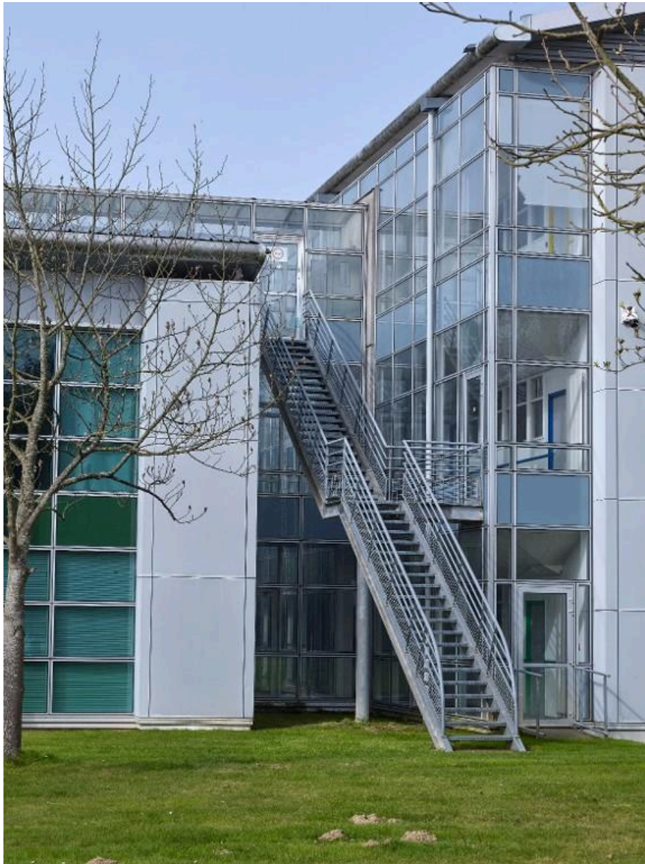
Vue partielle de la façade est du bâtiment principal. Joël Y. Gautier, architecte, 1992.
