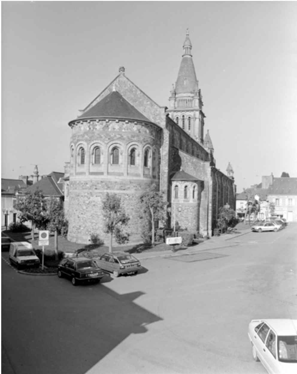
Elevation est : vue générale
