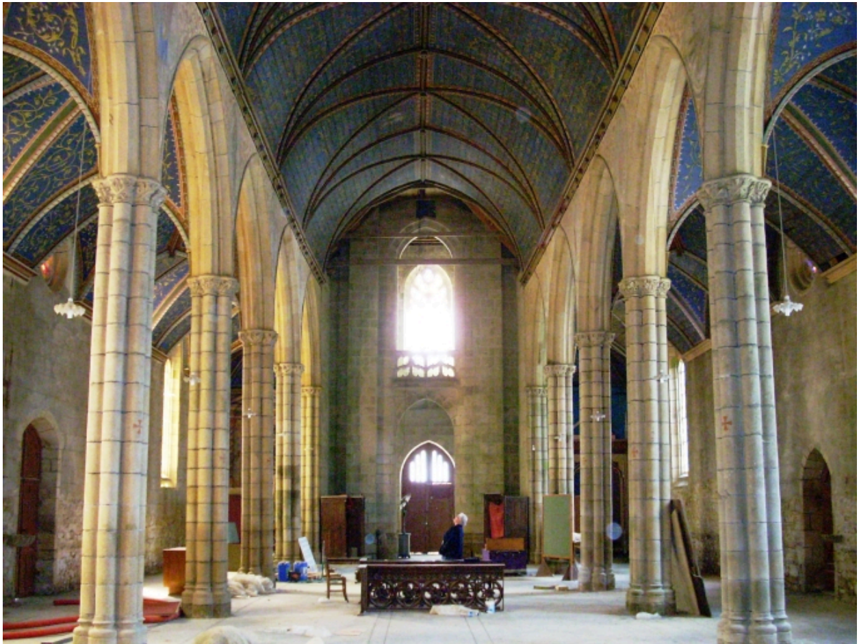
Plouigneau, église paroissiale Saint-Ignace : vue axiale ouest
