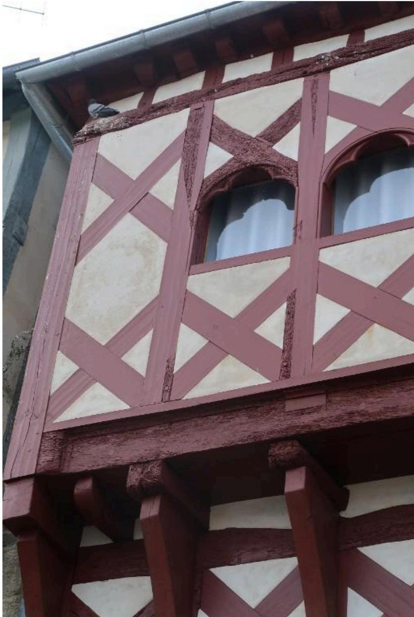
Cette fenêtre trilobée, découverte lors de la dépose de l'enduit ciment, a servi de modèle pour la restitution de la claire-voie.
