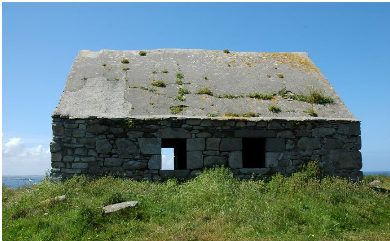
Ile de Batz : vue du corps de garde Ouest
