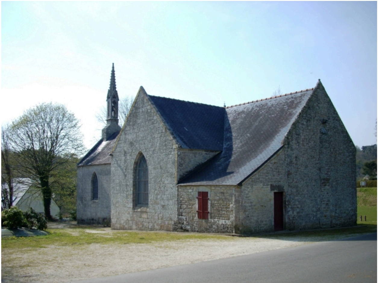
Elliant, chapelle Notre-Dame-de-Bon-Secours : vue générale sud-est
