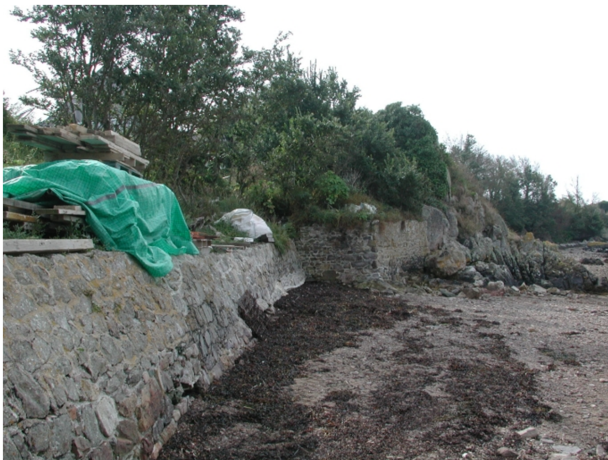
Vue du mur-digue de soutènement
