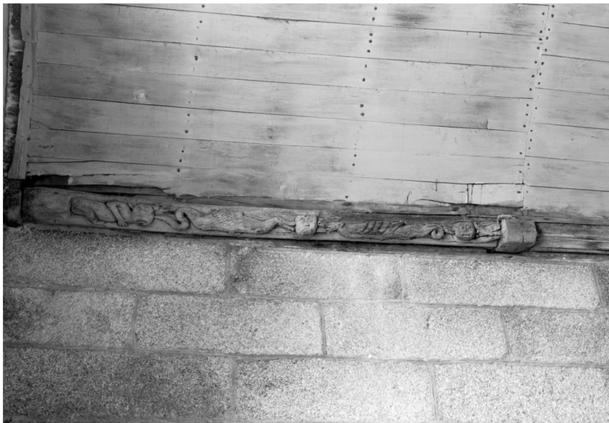
Croisillon sud, mur ouest : détail de la sablière
