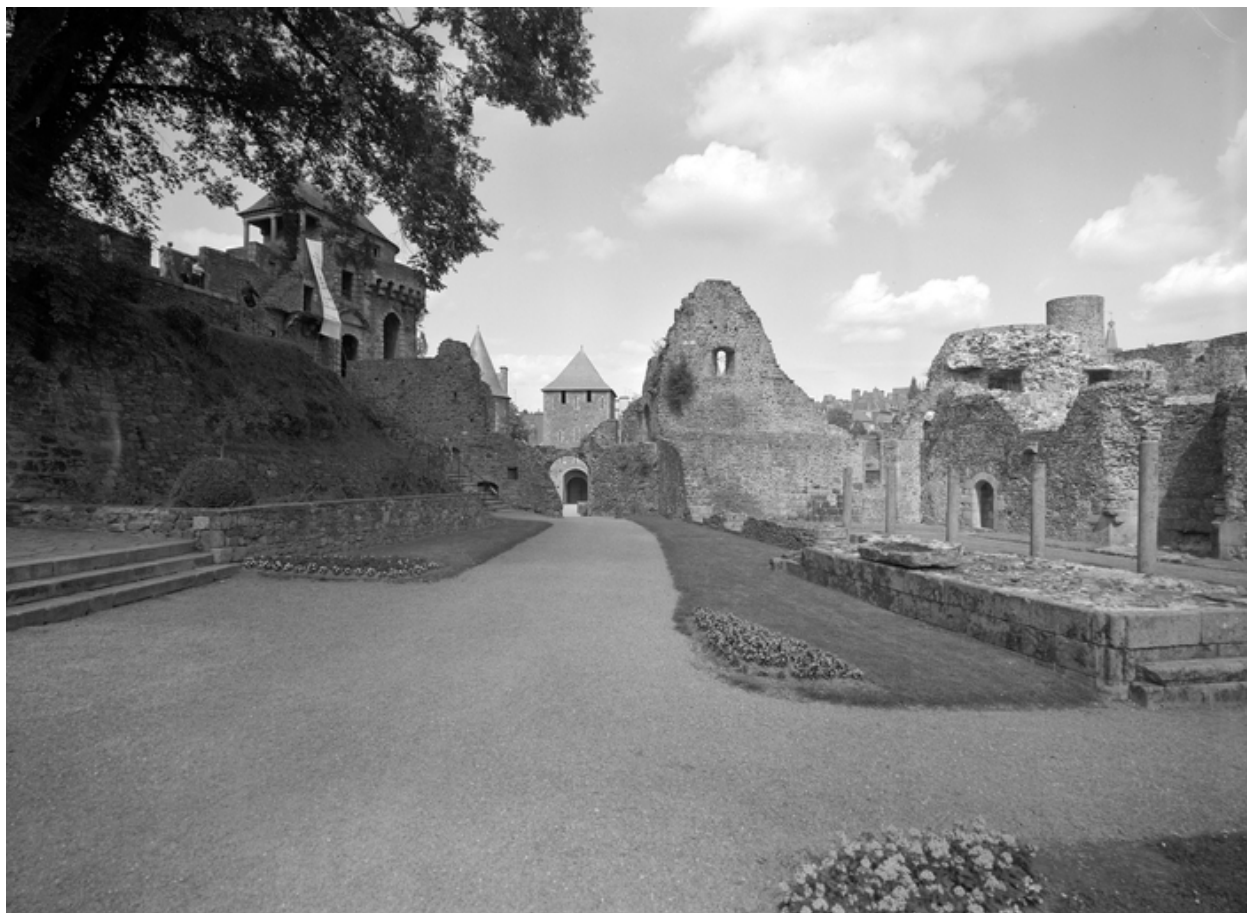
Vue générale vers l'est.
