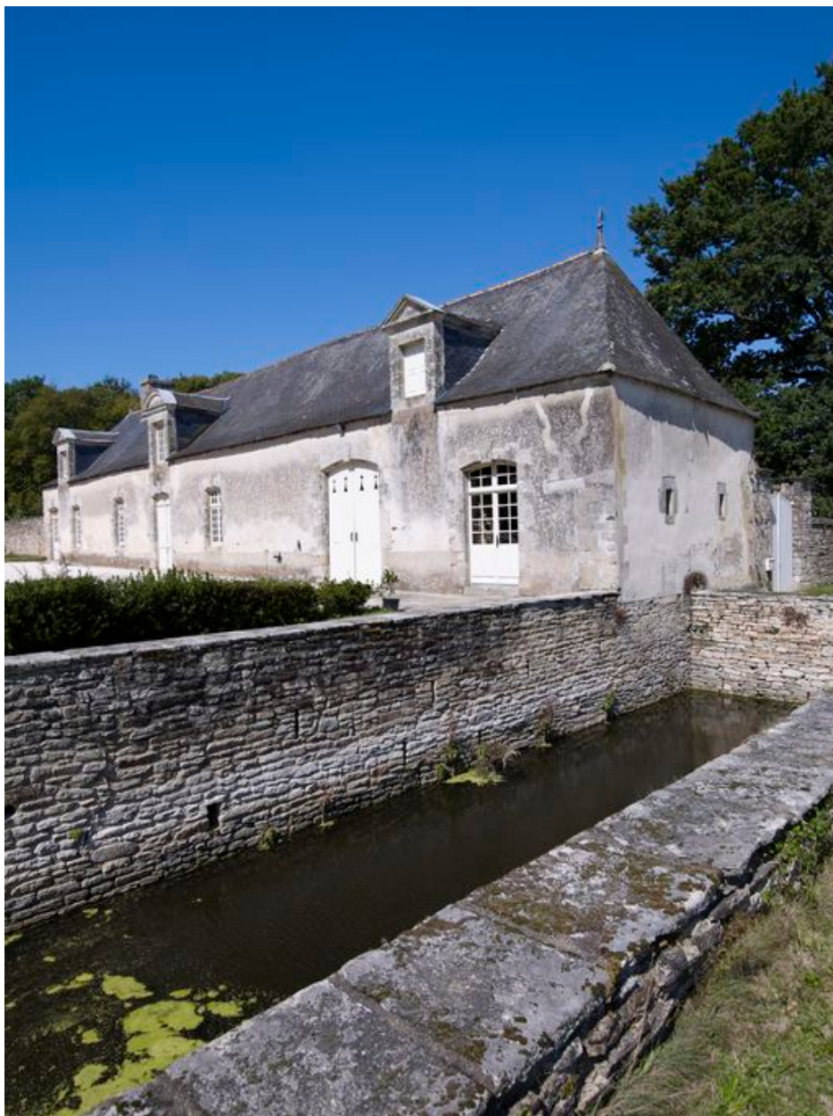
Château : les douves et la dépendance nord (état en 2010)
