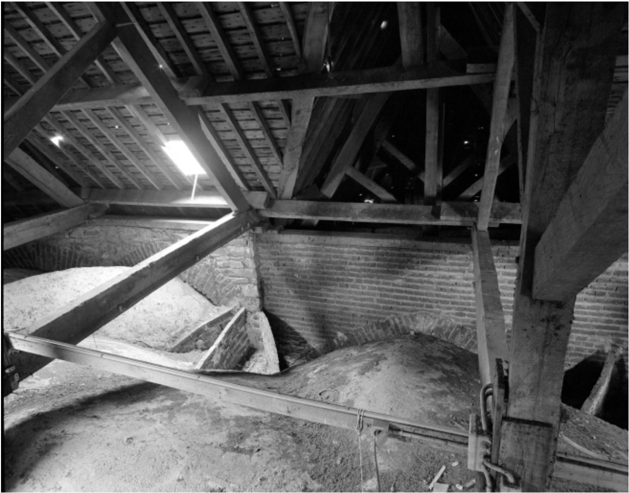
Charpente, vue générale vers l'ouest.
