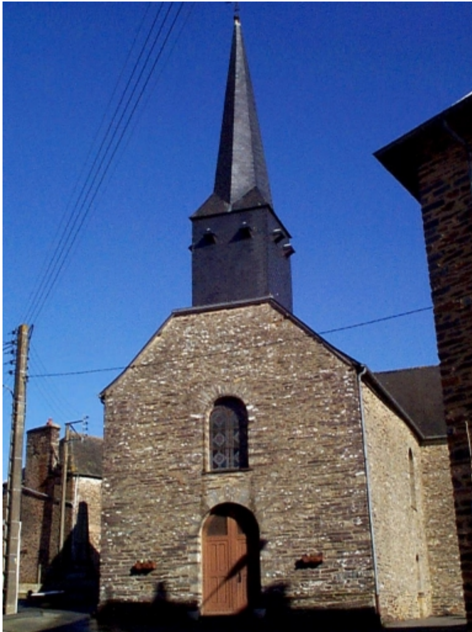
Le clocher : vue générale sud-ouest
