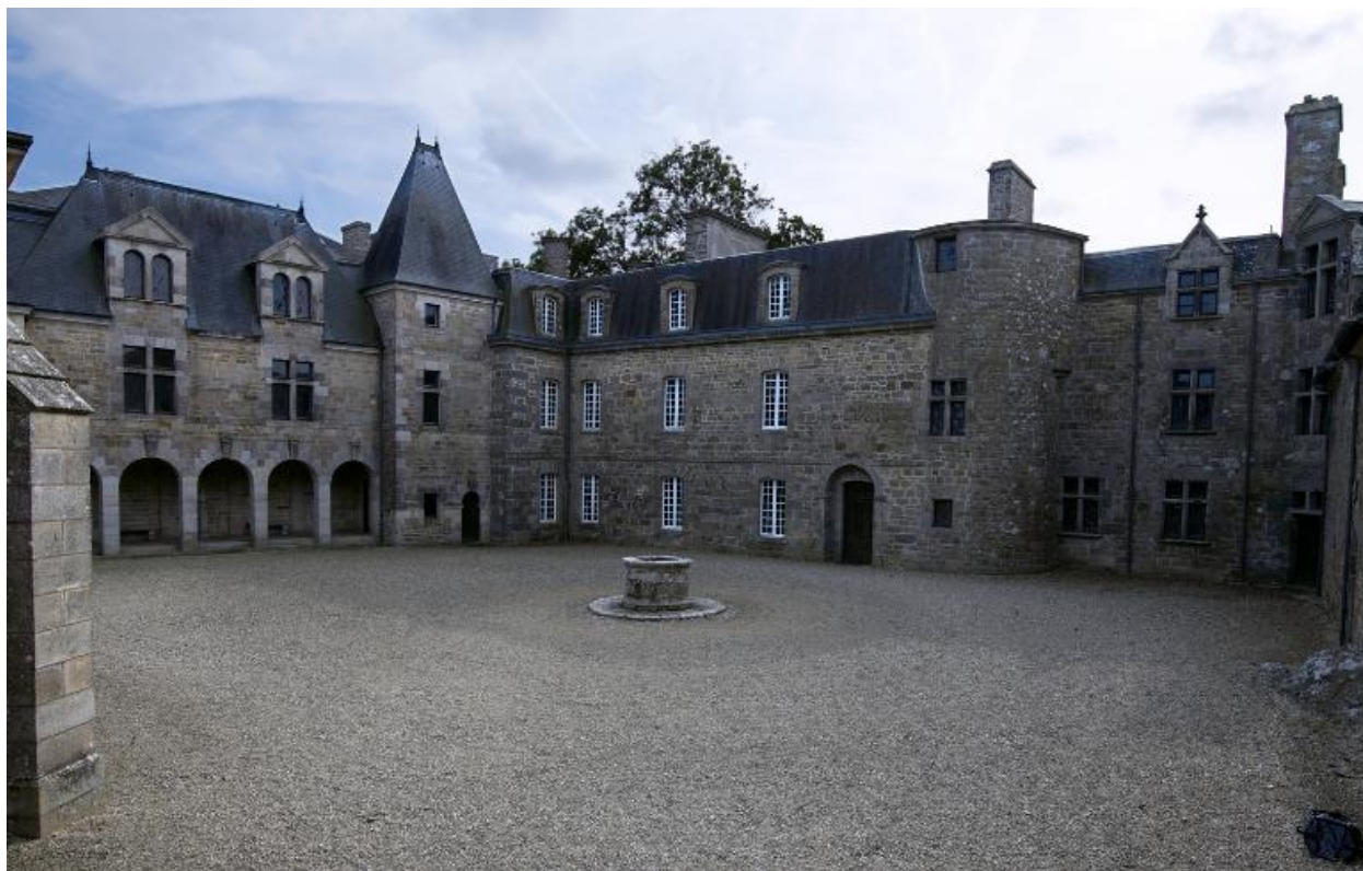
Vue de la cour et des élévations sud et ouest
