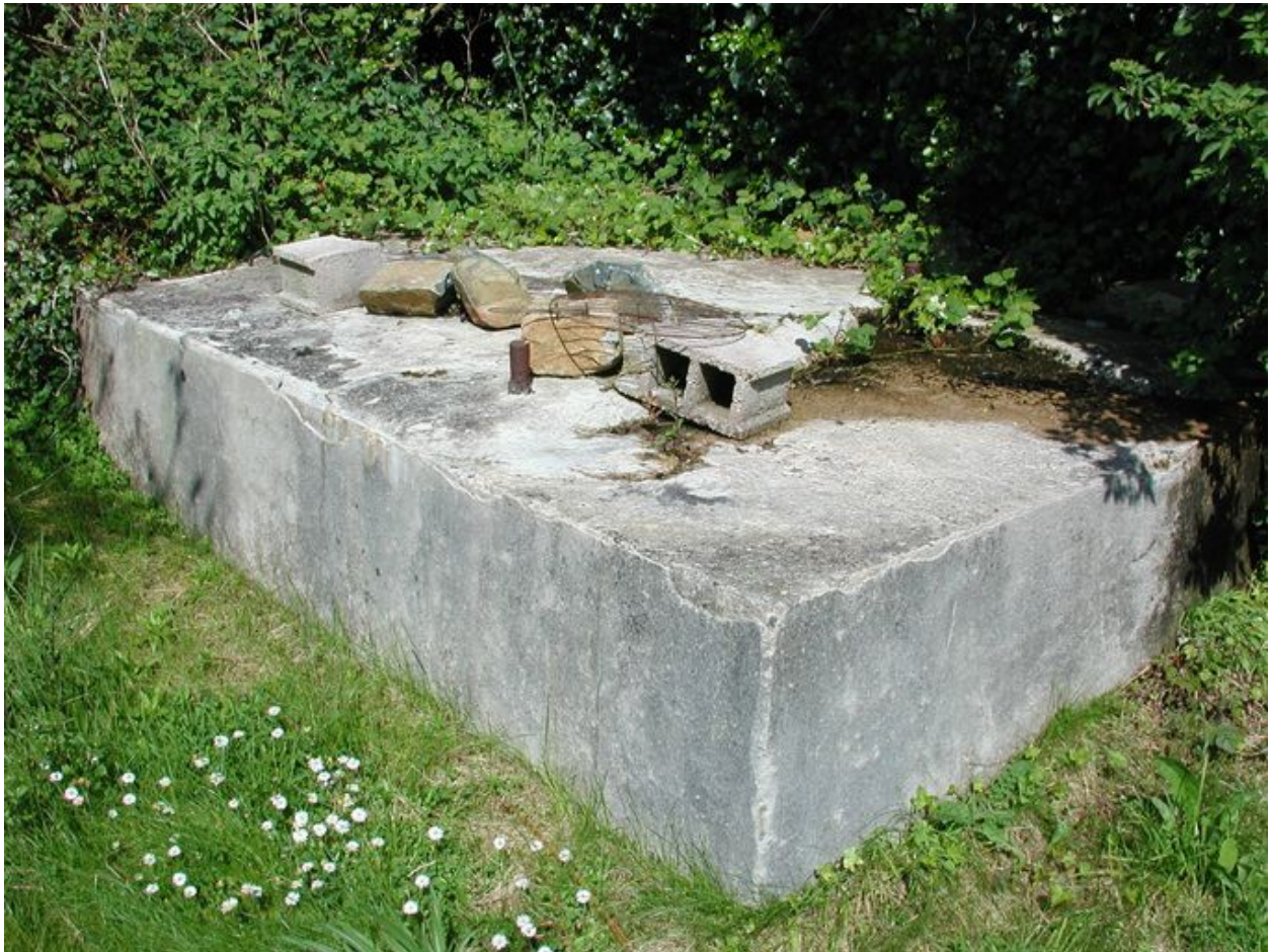
Vue de l'un des supports de mât pour l'antenne (état en 2002)
