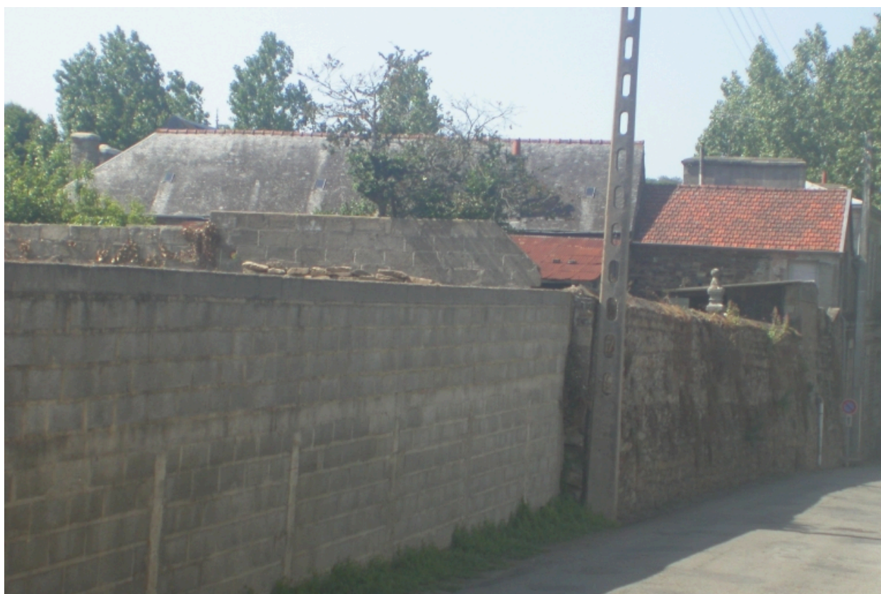
Vue depuis le sud
